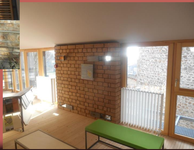
Cloison en bloc de chanvre et puit de lumière
