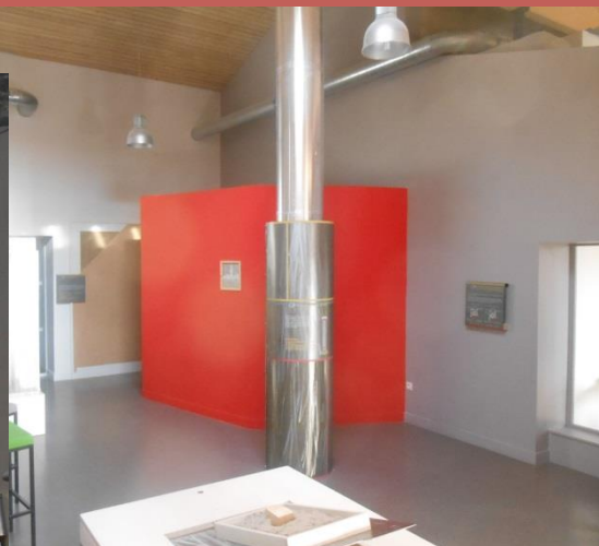
Cloison en bloc de chanvre et puit de lumière
