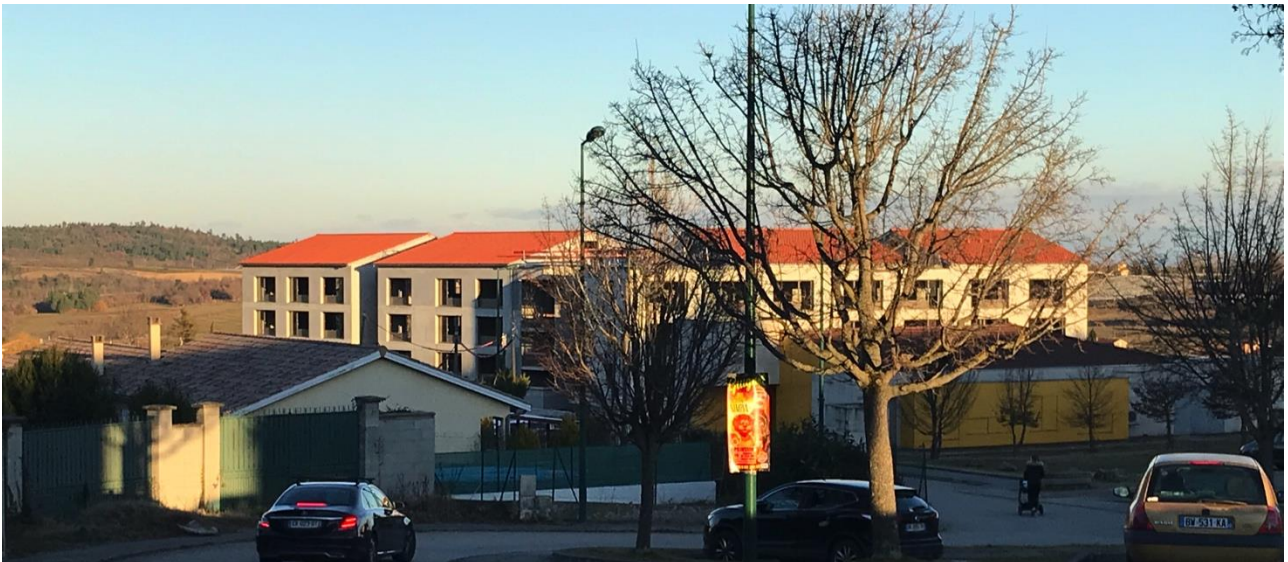
Le futur foyer logement - Photo Atelier du Triangle
