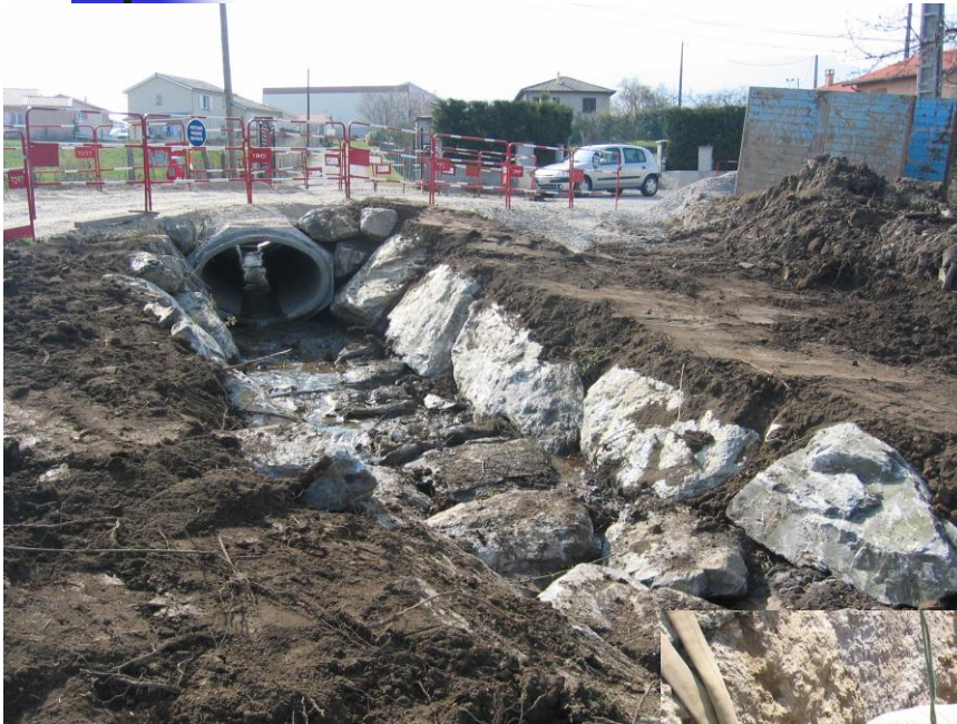
Enrochements eaux pluviales
