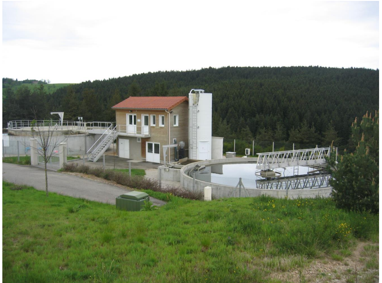
Station d'épuration de St Genest Malifaux
